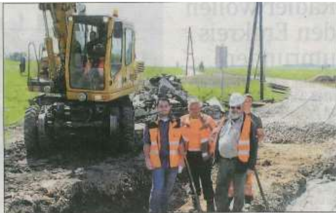
Michael Oberhauser (im Bagger), Michael Tschudnig, Harald Überreiter, Günther Stadler und Christopher Rus (v.l.) sind mit der Sanierung von 230 Metern Gleisstrecke der Bahnstrecke vom Bahnhof Langau Richtung Geras noch bis Monatsende beschäftigt. Foto: Robert Schmutz
