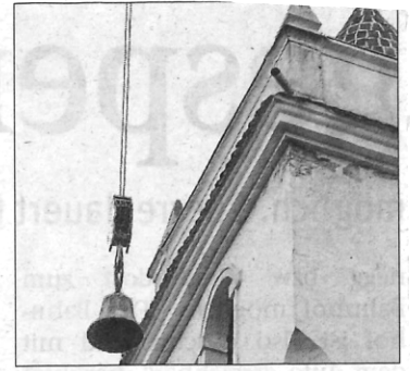
Die Pernegger Glocke wird hochgezogen und in den Turm gehievt.
