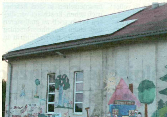
◀ In den letzten Tagen wurde auf dem Dach des Heizhauses eine 25 KwP-Photovoltaikanlage montiert. Fotos: Rupert Kornell
