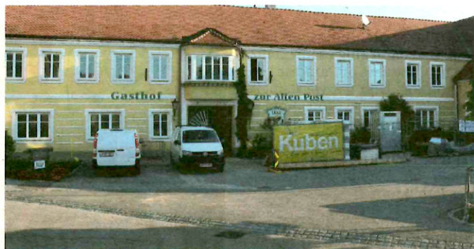
▲ Die Gemeinde Langau errichtet vor dem "Gasthof zur Alten Post" am Hauptplatz ein Rigol. Foto: Thomas Weikertschläger
