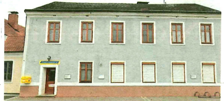
Das alte Arzthaus in Langau wird ab Mitte September abgerissen. An seiner Stelle soll ein neues Arzthaus errichtet werden, in dem neben einer Ordination auch fünf Wohnungen untergebracht sein sollen.
